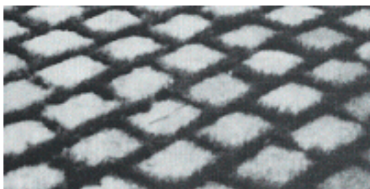
Kuva ruhosammatusta laatoituksesta (Timo Soini: Viherrakentajan käsikirja)
