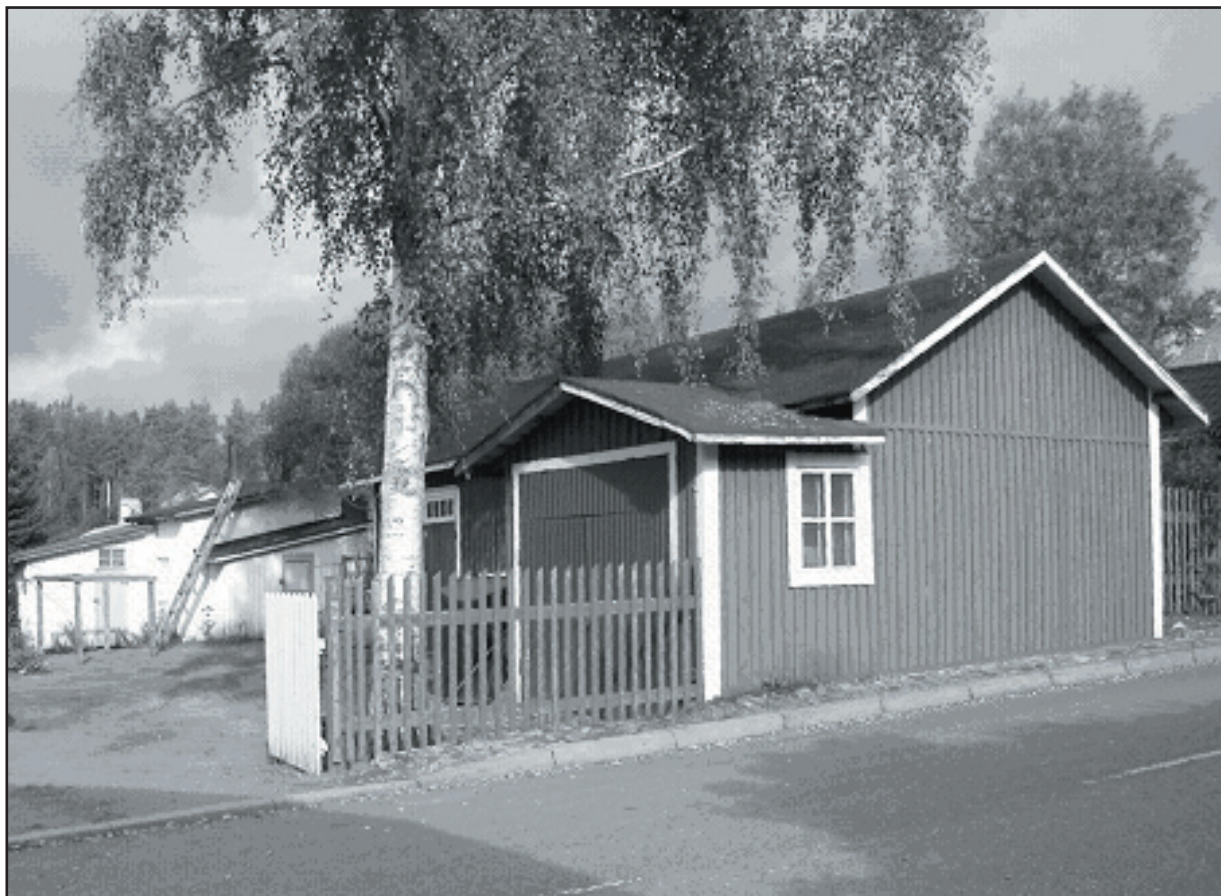
Piharakennus, johon lisätty autotallille tilaa laajentamalla rakennusta L:n malliseksi
