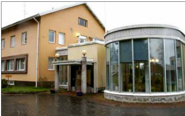
Laitushoito on tarkastuslautakunnan mielestä toiminut valtuuston asettamien tavoitteiden mukaisesti. Kuvassa Suonsaaren vanhainkoti.
